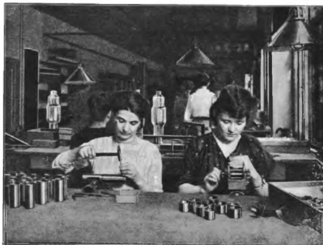
Fig. 7. Het rollen en klínken der anoden.
